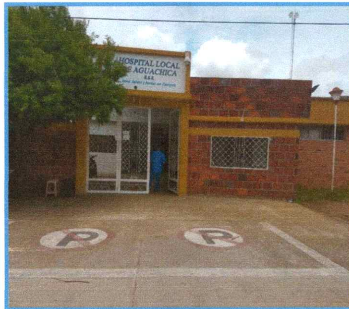
Imagen. Instalaciones del Hospital Local de Aguachica (Sede Principal)
