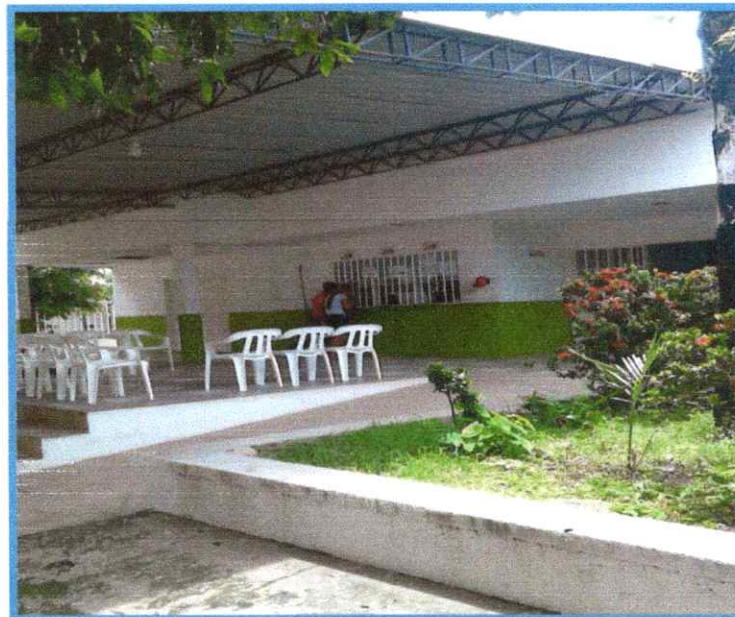
Imagen. Instalaciones del Centro de Salud San Eduardo
