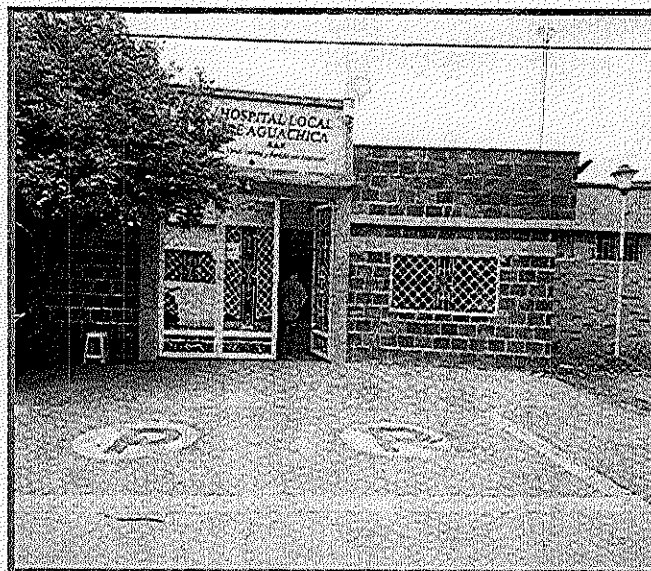
Imagen 1. Instalaciones del Hospital Local de Aguachica (Sede Principal)
